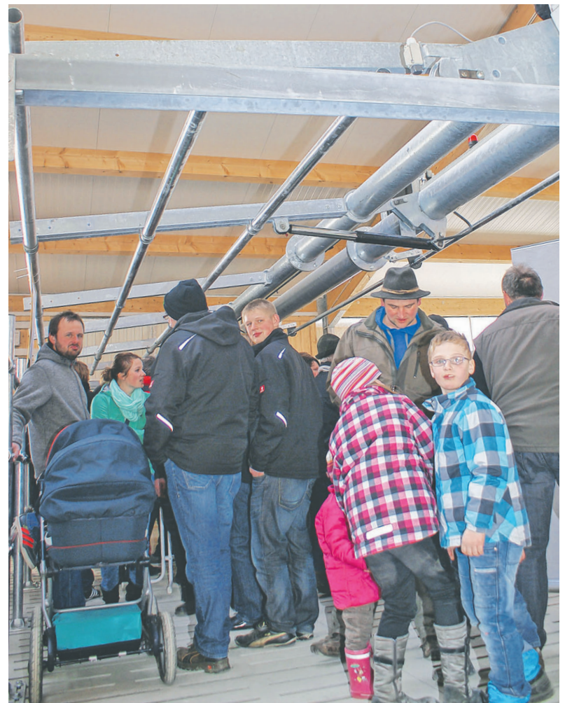
Die Treibhilfe (die über den Gästen zu sehen ist), ist über Kette und Ritzel per Funk-Fernbedienung zu steuern. Hier entschied sich die Familie Stork für eine massive Ausführung der Firma Happel.
