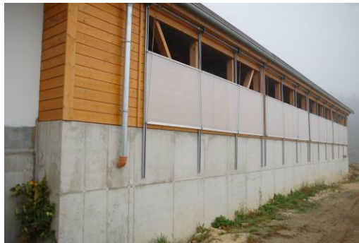
Der Warteraum lässt sich über Hubfenster einfach belüften.
