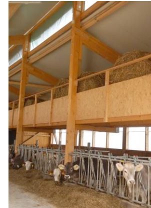
Jungviehstall mit Shed- dach und Strohbühne
