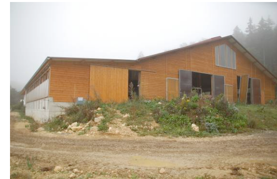
Unter dem flachen Teil des Daches ist der Anbau für Melkstand und Warteraum untergebracht. Warteraum und Melkstand fassen auch zu Beginn des Melkens sämtliche Kühe; der Schieber ist mit einer Treibhilfe ausgestattet.
