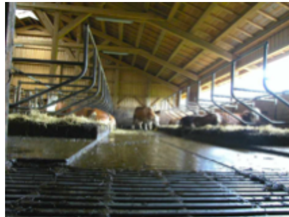
Ein Gitterrost über dem Gülleabwurfschacht ermöglicht einen stufenlosen Zugang zum Melkstand.
