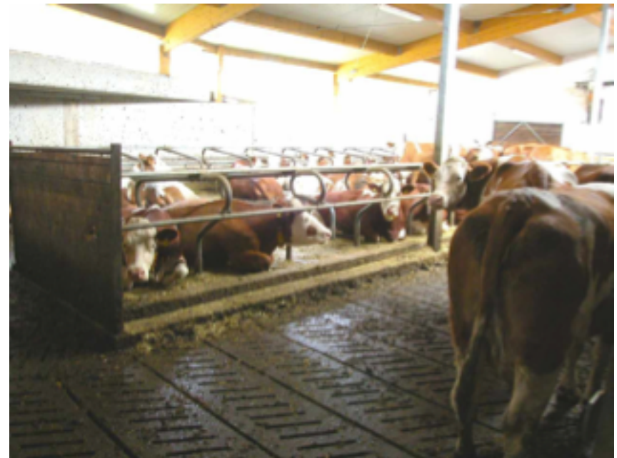
Diagonale Flächenspalten und bequeme Hochboxen, viel Licht und Luft bestimmen den Stallneubau.
