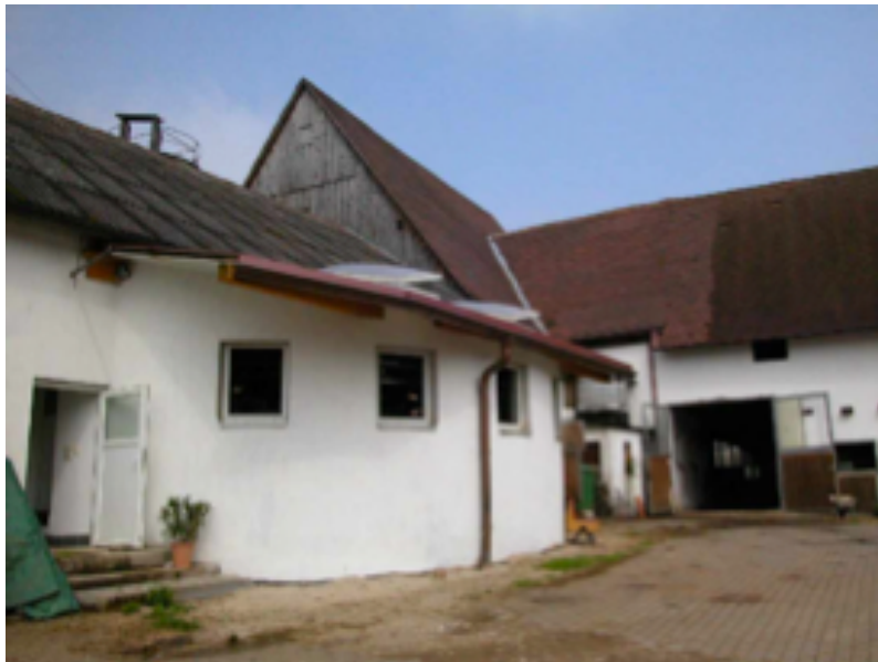
Das Melkkarussell wurde harmonisch im Altgebäude integriert. Dachfenster ermöglichen eine gute Luftführung auch im Sommer.
